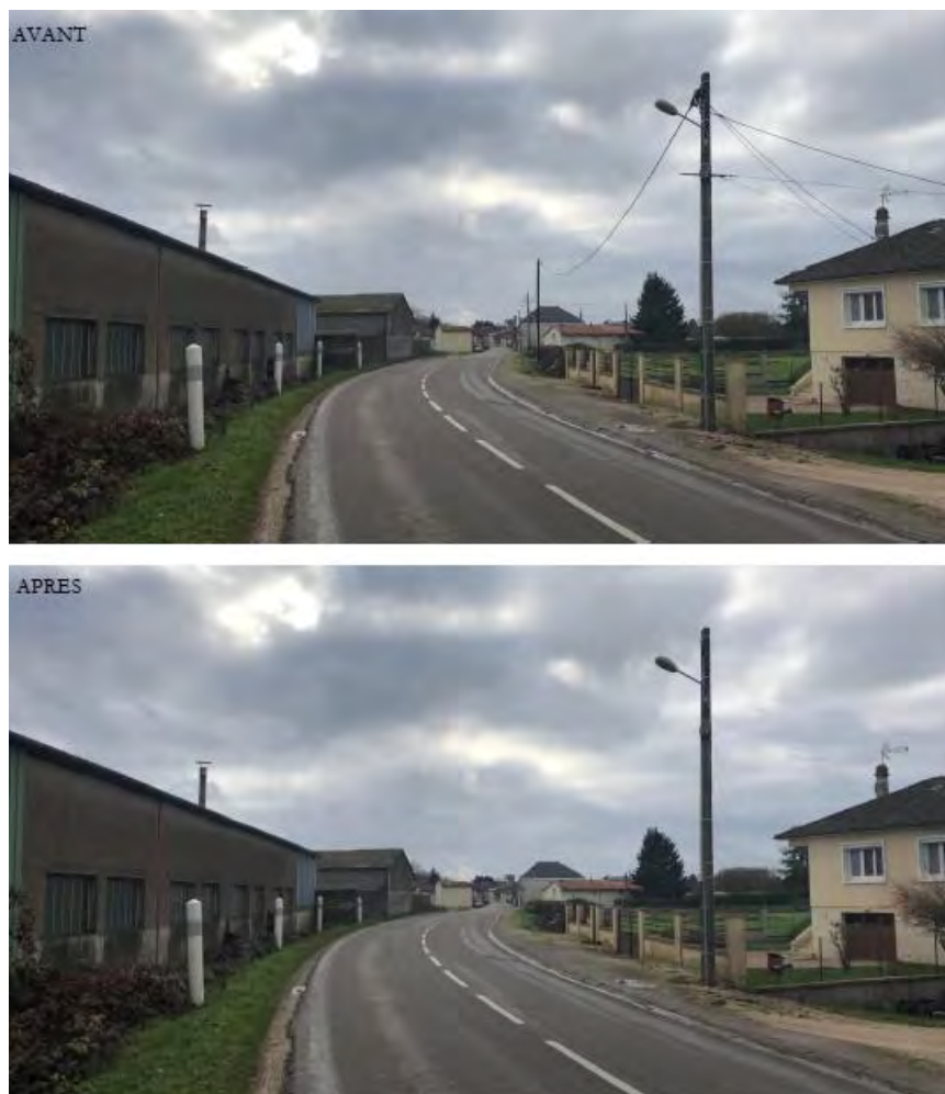
Image n°5 : Vue depuis l'entrée Nord de Pringy avec et sans les lignes électriques et téléphoniques
